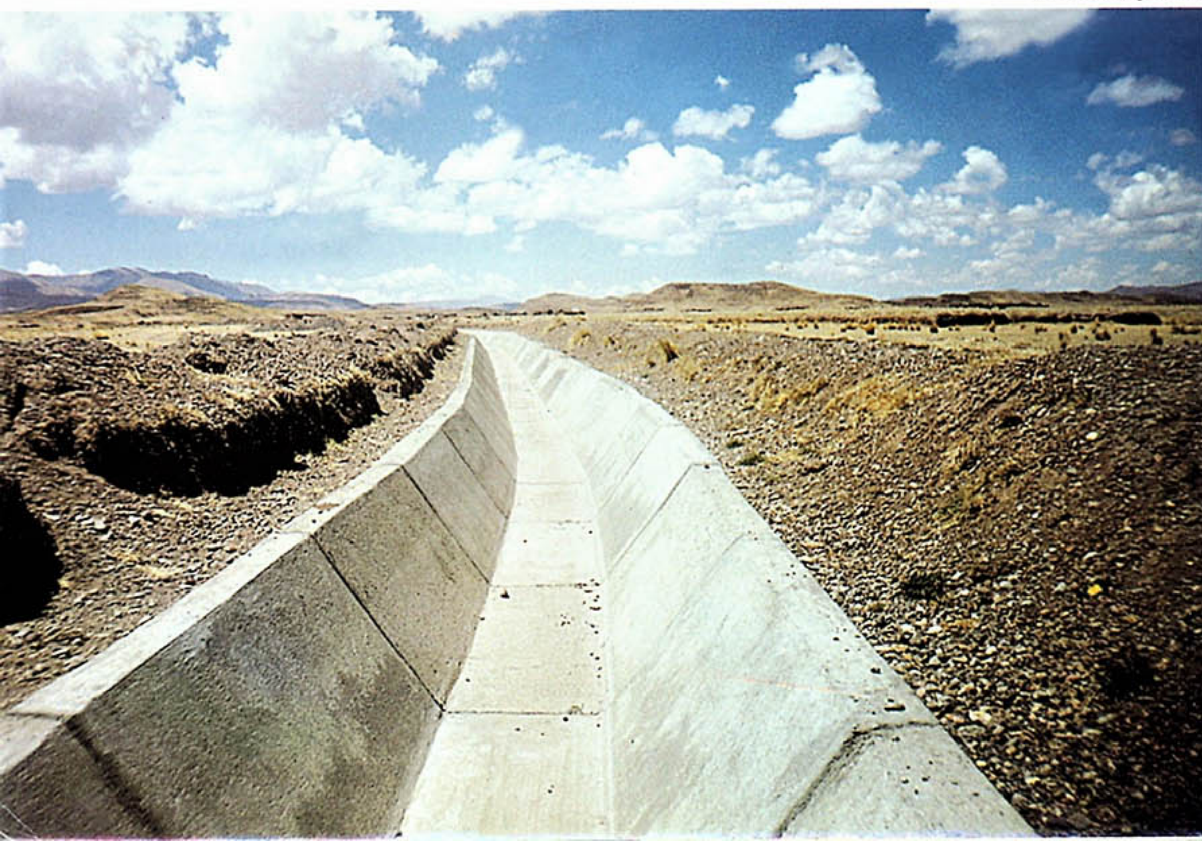
Canal de Riego - Puno
