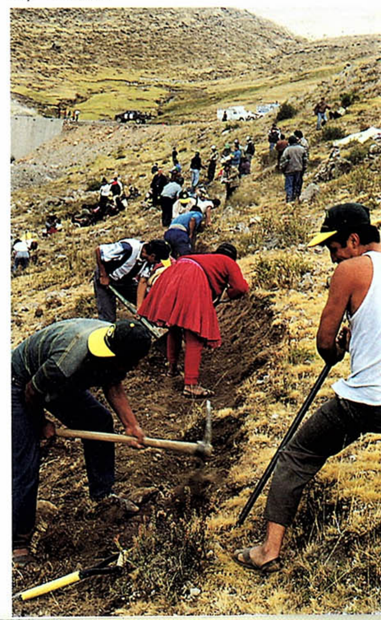
Zanjas de Infiltración
